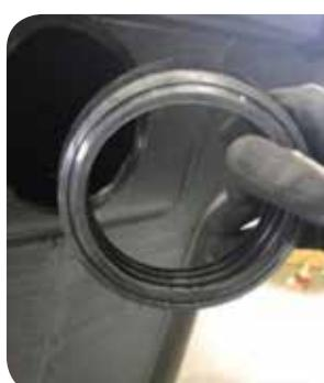
Die beiliegenden Dichtungen einsetzen (Einbaurichtung beachten)
