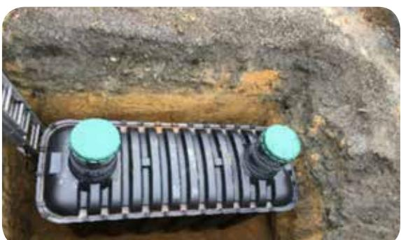
Absetzen des Tanks am Boden der Baugrube
