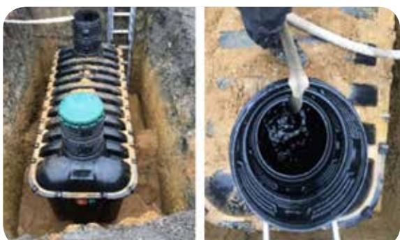
Verfüllen mit selbststabilisierendem Sand mit konstanter Höhe (gleichzeitiges Befüllen mit klarem Wasser)
