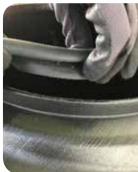
Dichtung des Mannlochs einsetzen
