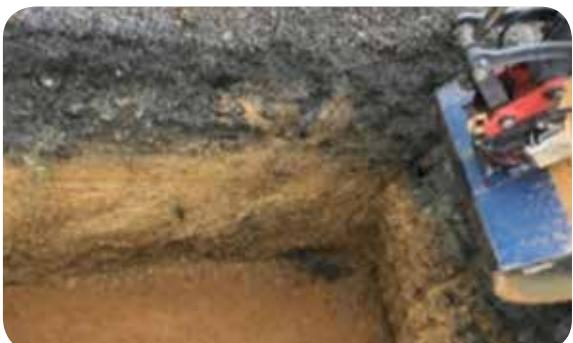
20 cm Sand am Boden der Baugrube
