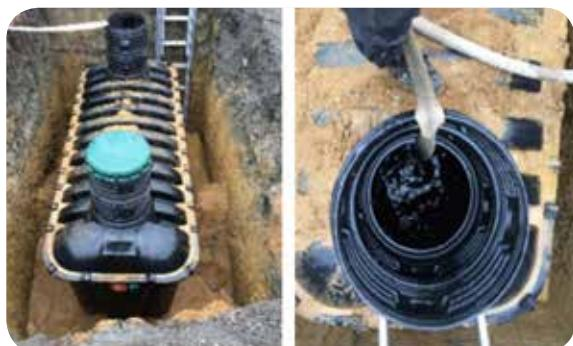
Remblaiement au sable autostabilisant à niveau constant (remplissage simultané en eau claire)
