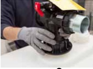
5- Visser le raccord de base **1** légèrement sur le réservoir.
