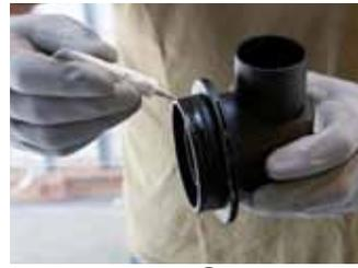
15- Mettre de la graisse **6** sur le joint du coude d'aération Ø70 **8**.
